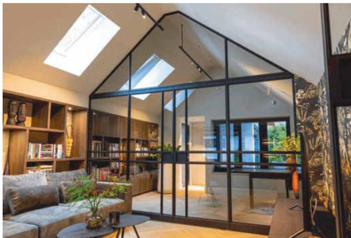
*/ Made by Keizers: Die Stahlprofile der De-Rooy-Lofttüren werden grundiert und mit widerstandsfähiger 2-Schicht-Pulverbeschichtung in Wunsch-RAL-Farbe versehen.*
